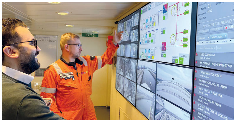
Maikel Malki, HEROSE Area Sales Manager, mit Daniel Henning, AIDAnova Staff Chief Engineer, vor den Motorkontrollanzeigen im Engine Control Room.
